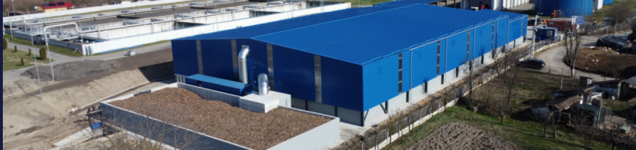
*Stația de compostare a nămolului Câmpia Turzii
