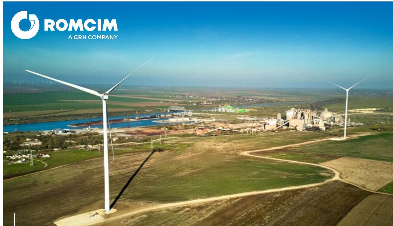
Parcul eolian pentru alimentarea fabricii de ciment Medgidia, Constanța
