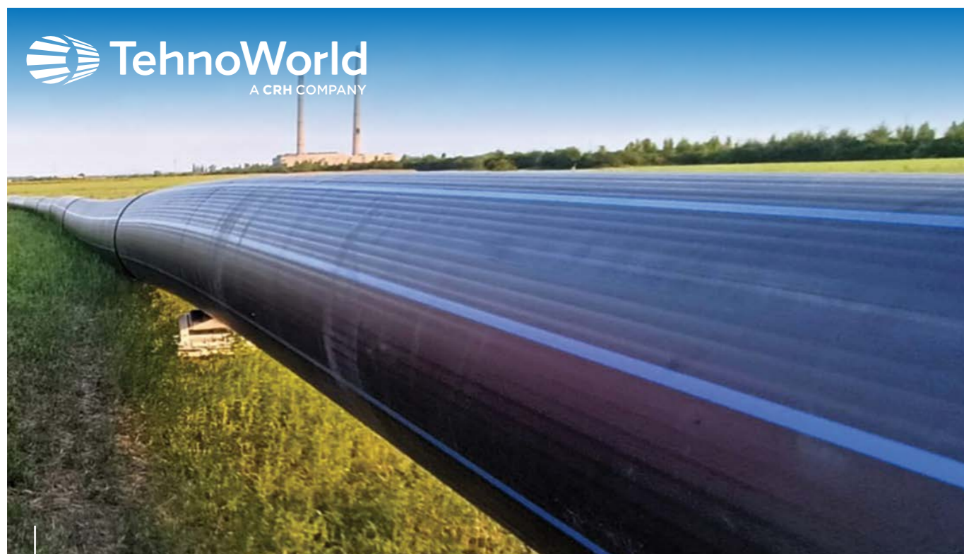
Aducțiune de apă potabilă în municipiul Brăila
