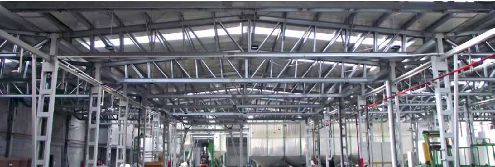
Hală depozit Rm. Vâlcea - 3150 mp
